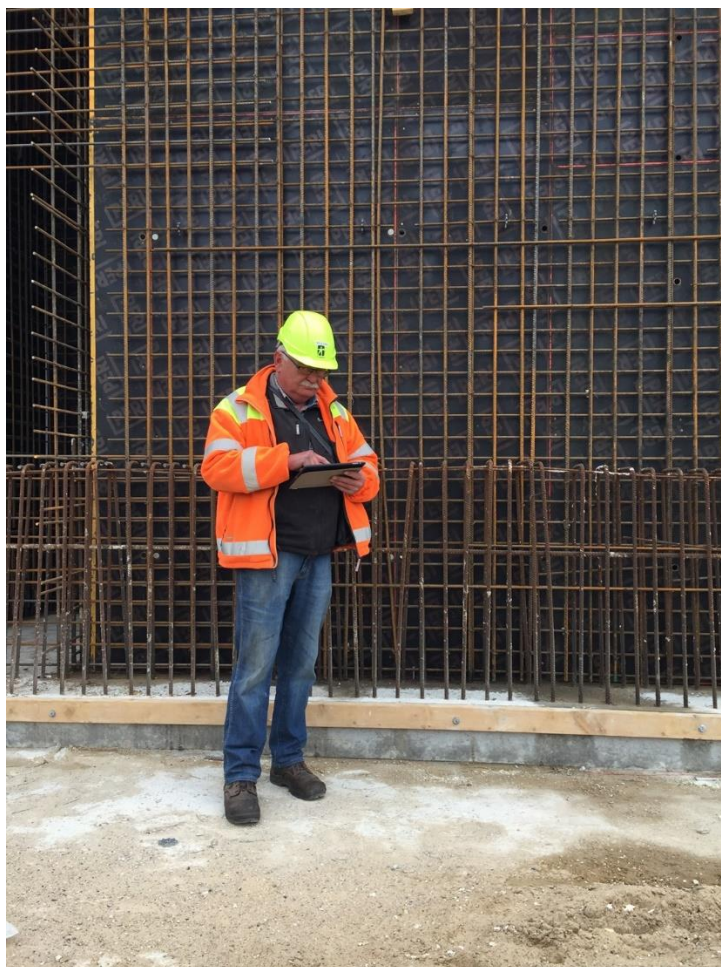
NAU MT Højgaards formænd og byggeledere har adgang til BIM-modellen og alle konstruktionstegninger på deres iPad - og de har taget det ivrigt til sig
