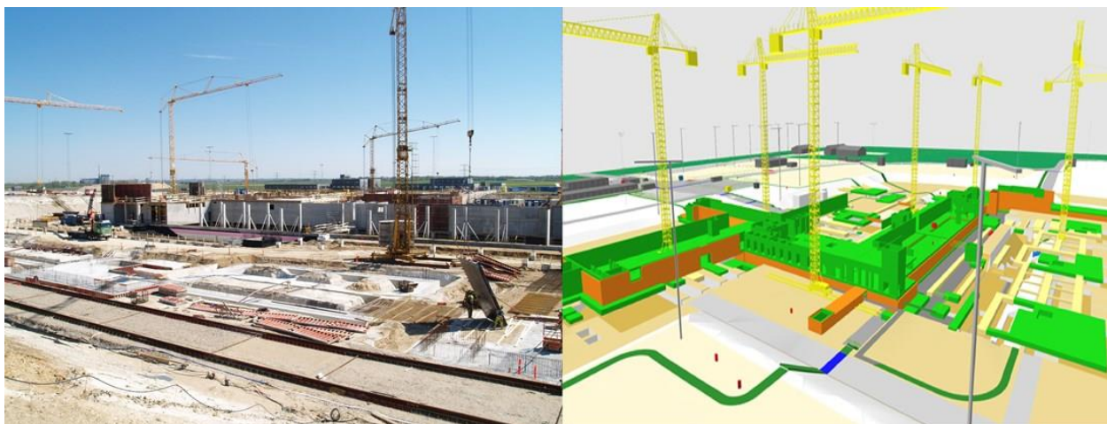
Byggepladsen på NAU og BIM-modellen af den
