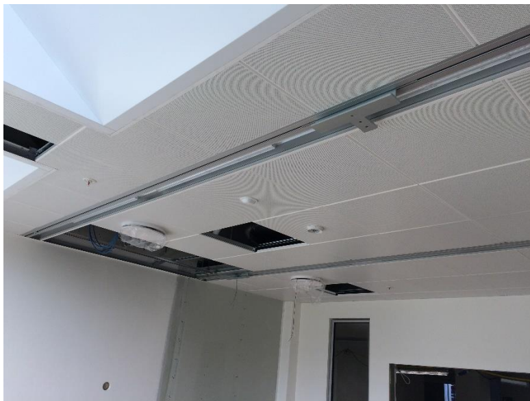
Det holdt hårdt, men løsningen blev fin: Sådan blev patientliftenes skinnesystem integreret i loftet.
