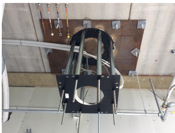
Forsyningssøjlels fastgørelse i lofterne. Søjlerne vejer 300 kg og kan drejes og bevæges, så fastgørelsen skal kunne magte et relativt stort moment.
