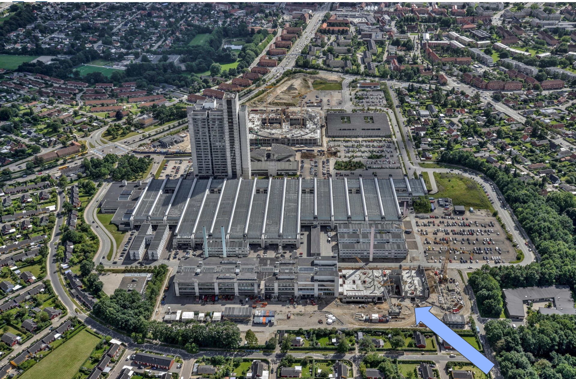
RSH- byggepladsen august 2016
