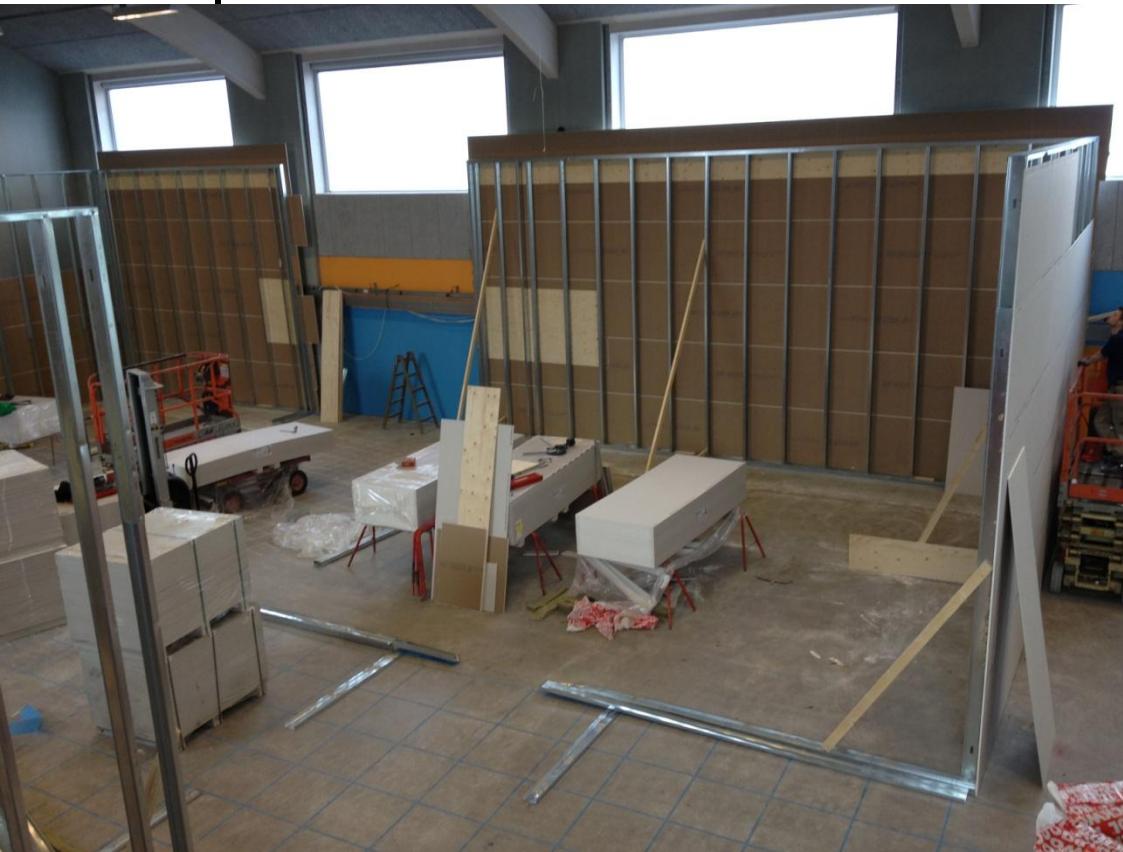
Opbygning af 1:1 mock-up
