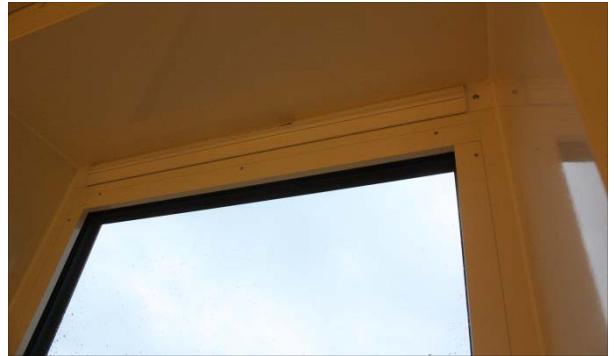
Ventilationsventil indbygget i overkarm. Manuel klap i svær aluminiumsudførelse.
